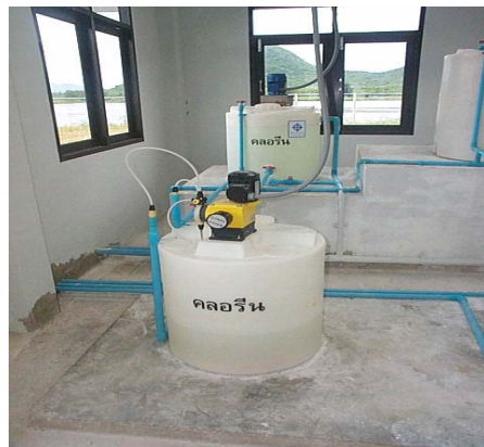
รูปที่ 20 เครื่องจ่ายสารละลายคลอรีน
